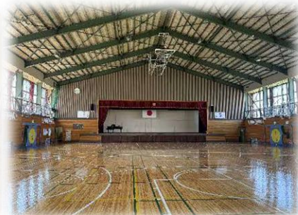
既存屋内運動場
