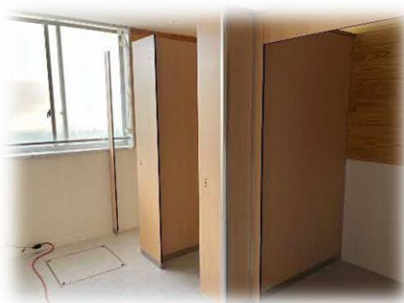
既存校舎のトイレ
