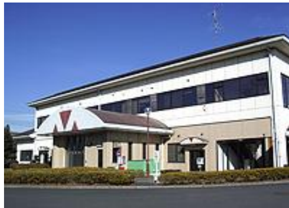
八甫清掃センターし尿処理施設
