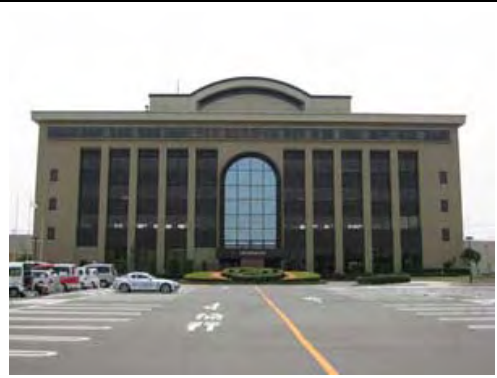
鷺宮総合支所
