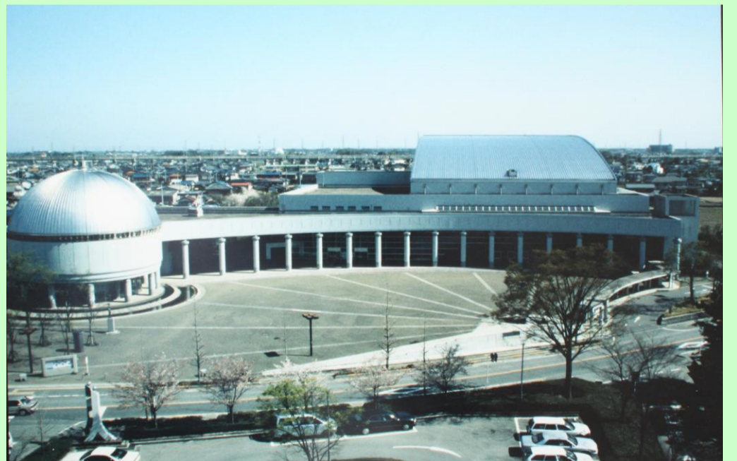
「久喜総合文化会館」(昭和62年建設)
