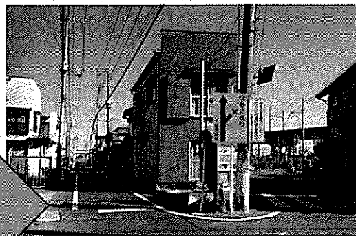
外側線で道路面がはっきりしました。安全対策進行中
