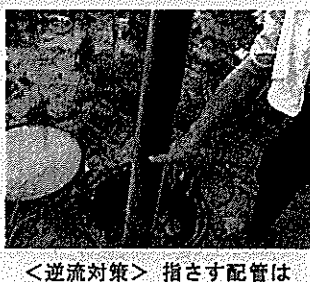
<逆流対策> 指さす配管は星川が満水した際の水位
