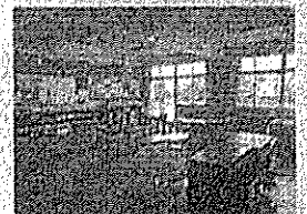
教室の改修、トイレの洋式化、照明のLED化、内装工事等大規模改修を実施
