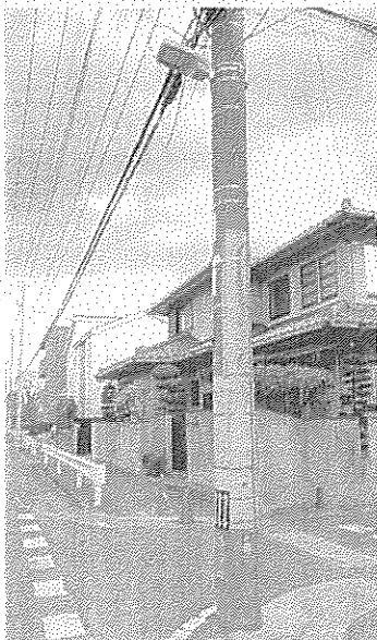
工事後（電灯部も交換）
