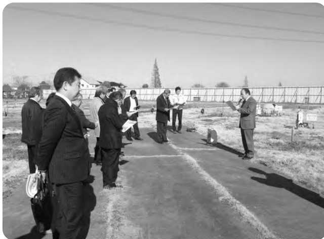
地下水位低下工法実証実験現場
