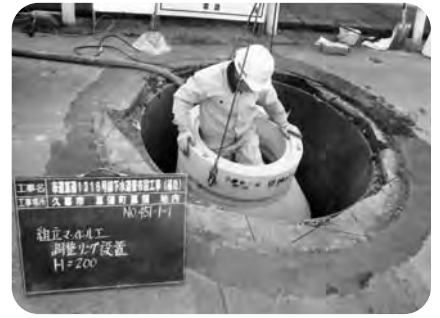
菖蒲5区地下下水道本管工事
