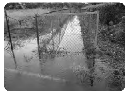
栗橋西中学校校庭からの水や土が流れ込み冠水。土砂の浚渫が必要(小排水路73号)
