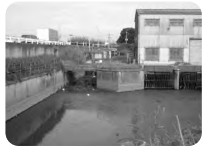
機能低下を招かないよう管理が必要な36間樋管
