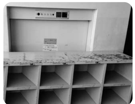
使われていない給食運搬用エレベーター
