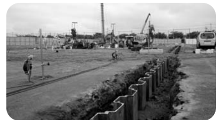
「地下水位低下工法」実証実験現場（南栗橋スポーツ広場6月24日）
