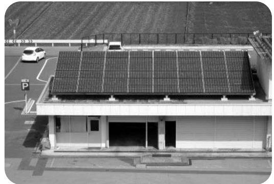
市役所車庫棟上の太陽光発電パネル
