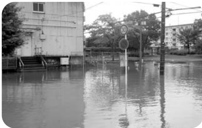
大雨で冠水したわしみや団地
