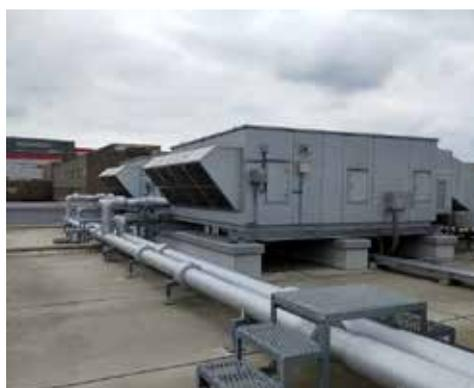
破損したコイルが格納されているエアハンドリングユニット
