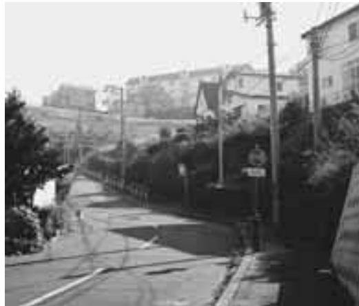
旧室蘭公園の入口部分の道路（本多が並木整備を提案した所）
