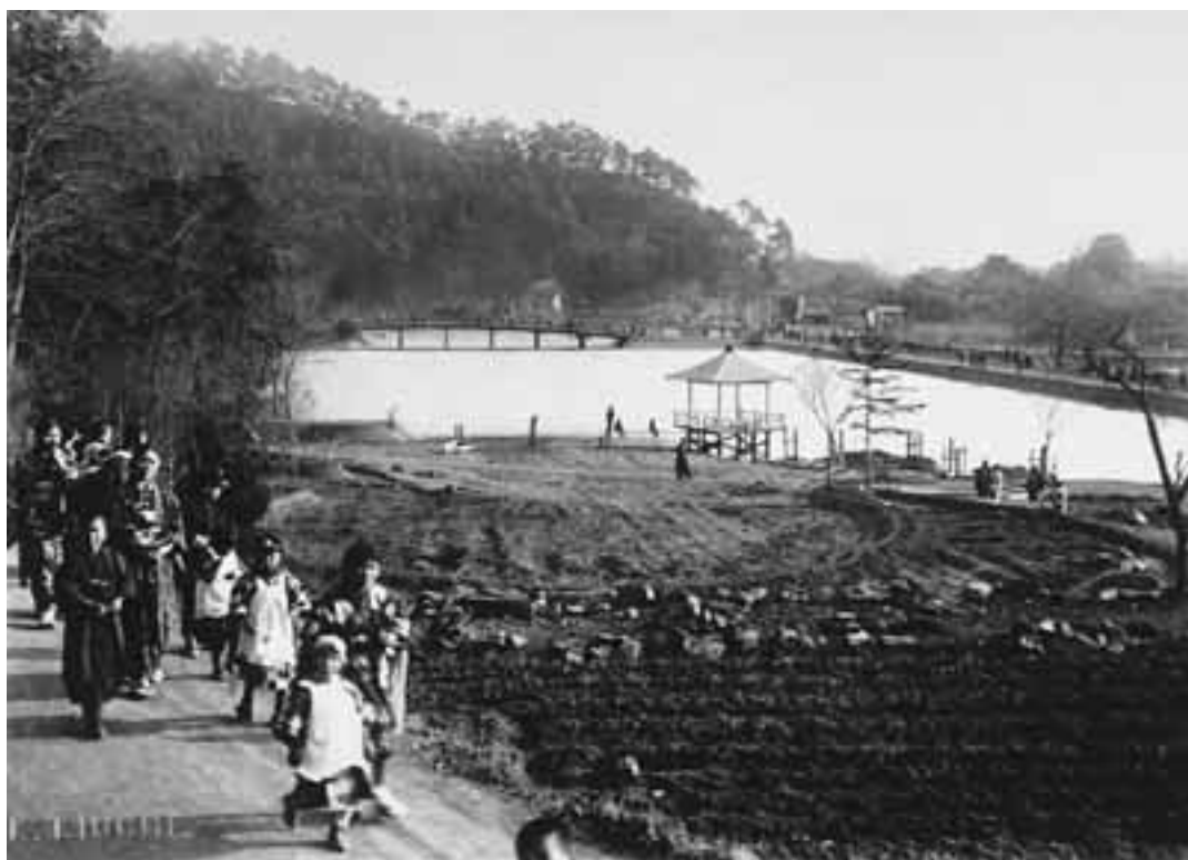
臥竜公園・竜ヶ池築造工事竣工後のようす（現 動物園入口方面を望む）
