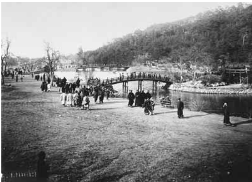
臥竜公園・竜ヶ池築造工事竣工後のようす（現 動物園入口から）
