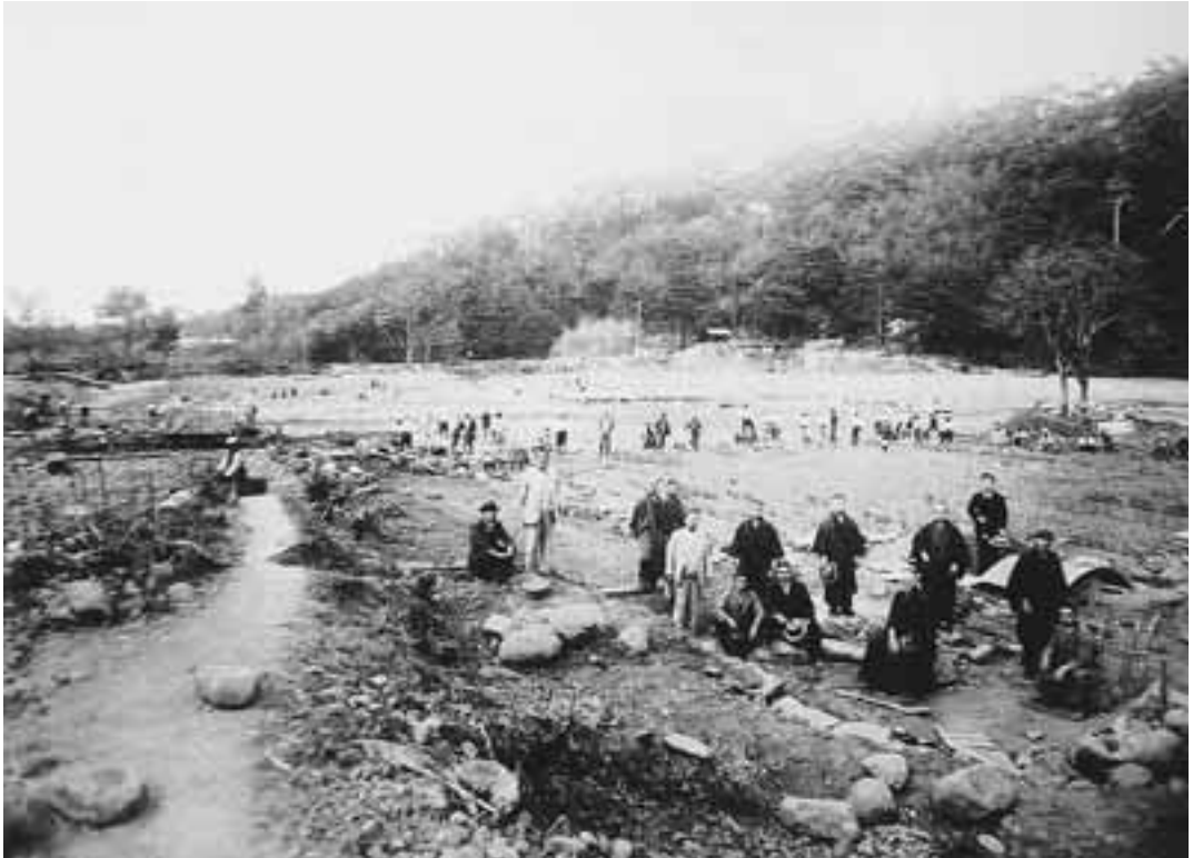
臥竜公園・竜ヶ池築造工事のようす
