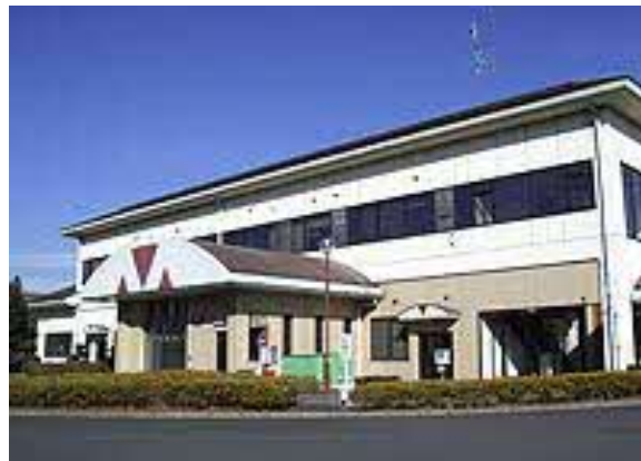
八甫清掃センター し尿処理施設
